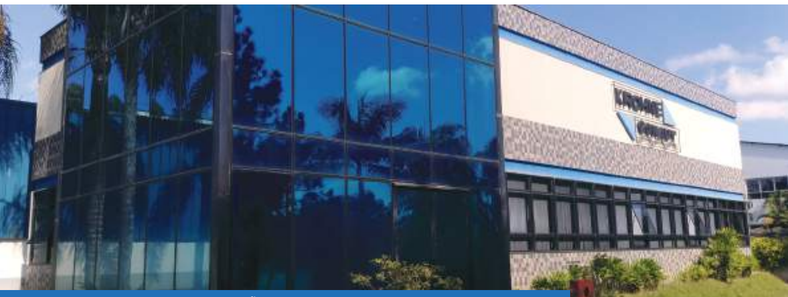
KCI - KROHNE CONAUT INSTRUMENTAÇÃO, localizada no parque industrial de Embu das Artes.
